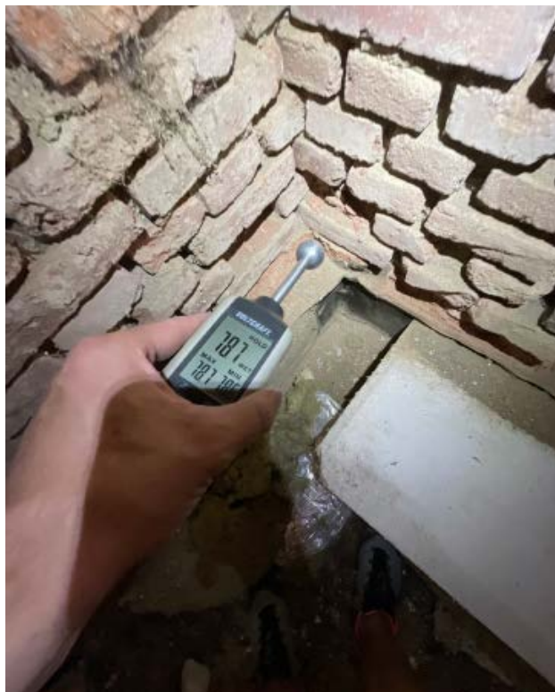
Spodní úroveň - Vlhkost 16%
