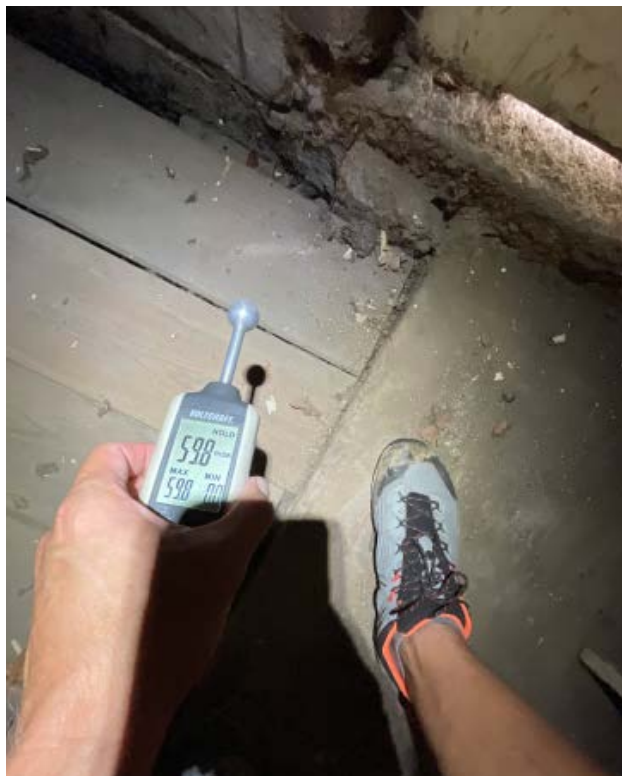
Spodní úroveň - Vlhkost 10%
