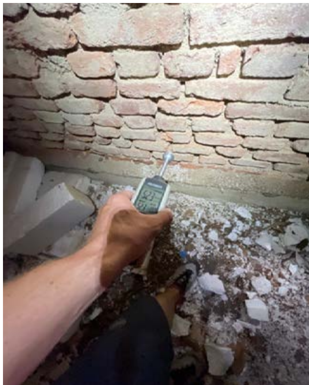
Spodní úroveň - Vlhkost 7%
